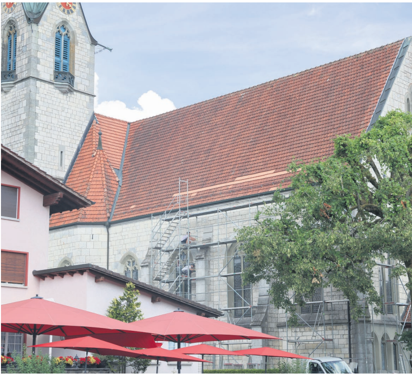
Die Kirche Maria Himmelfahrt ist unter Bundesdenkmalschutz. Für die Sanierung des Kirchendachs wurde das ganze Gebäude eingerüstet. FOTO RAMON WOLF/ARCHIV
