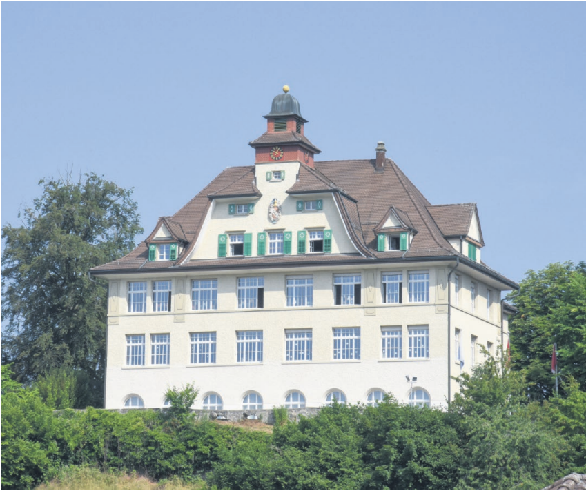
Das Burgschulhaus in Büron ist als schützenswert eingestuft. FOTO SZ/ARCHIV
