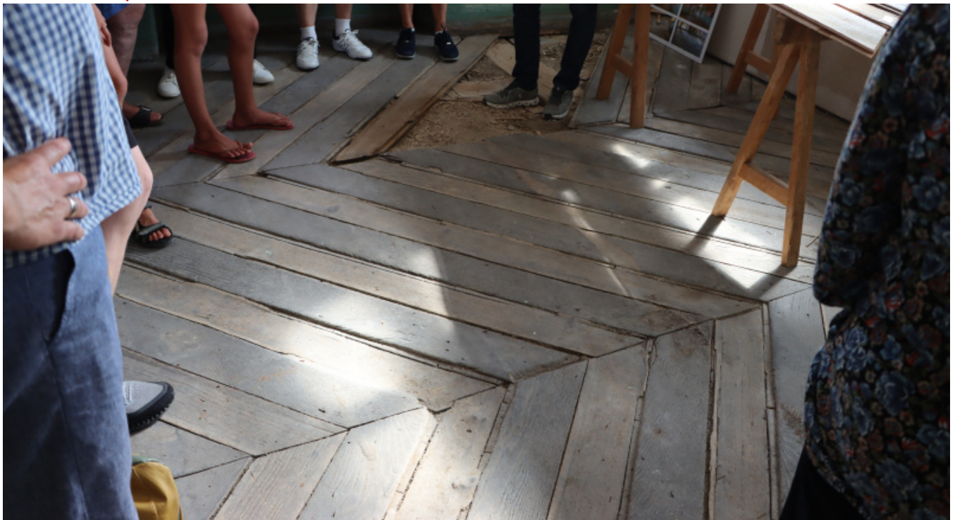
Und wie kriegt man einen solchen Boden unter Berücksichtigung der Denkmalpflege wieder in stand?
