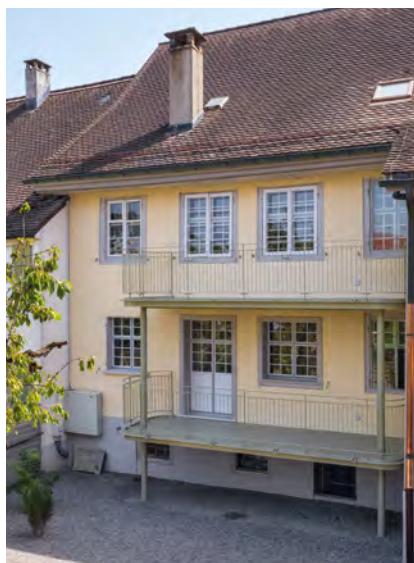
Gartenfassade nach dem Umbau, im EG mit rekonstruiertem Fassadenteil und neuen Kreuzstock-Fenstern nach historischem Vorbild.
