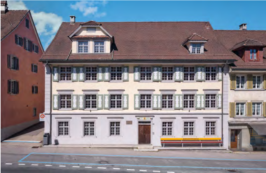
Das sogenannte Herzoghaus mit seiner frisch restaurierten Fleckenfassade. Die hölzernen Kreuzstockfenster unterschiedlichen Alters sind teils noch mit Einfachglas, teils als Doppelverglasung ausgeführt.
