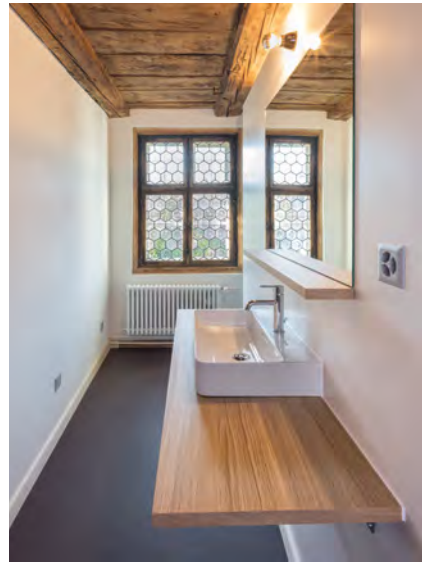
Badezimmereinbau in der Kammer mit dem einzigen erhaltenen Butzenfenster, 18. Jh., ergänzt durch neues Vorfenster.
