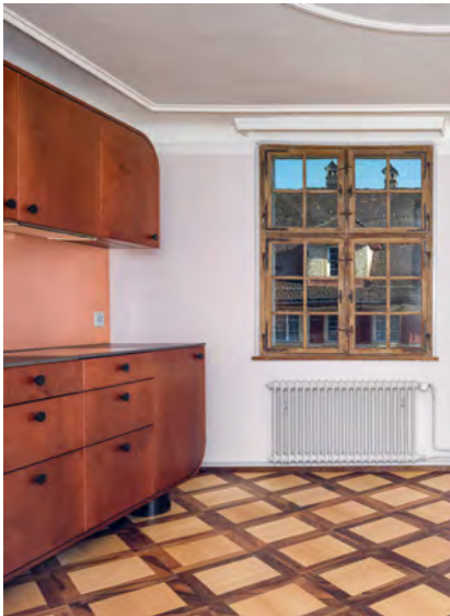
Stube mit Ausstattung wohl Anfang 20. Jh., neuem KÜcheneinbau und Sicht auf den Flecken durch die Ziehgläser der barocken, einfachverglasten Kreuzstockfenster.
