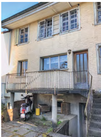
Nordseitige Gartenfassade vor der Restaurierung 2023; im OG eine Varietät von Kreuzstockfenstern mit Butzenglas, nachträglich eingepassten Sprossenkreuzen mit Ziehgläsern und diversen Vorfenstern.
