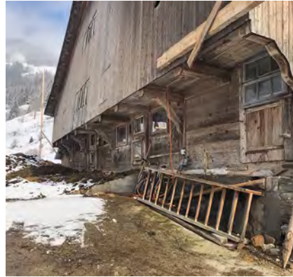
Flühli Steinibach 1, Steinibach-Scheune
