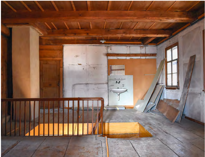
Schüpfeim, Arreggerhaus, Dachgeschoss vor dem Umbau
