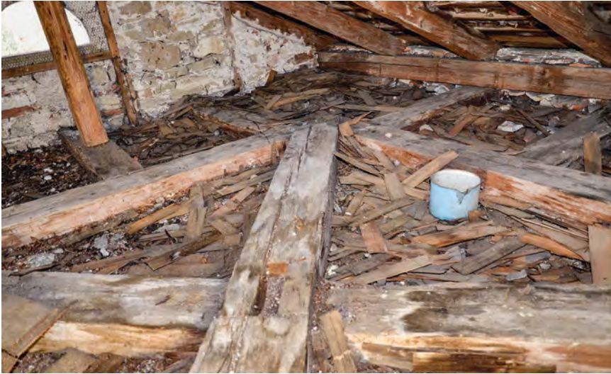
Basis des Dachstuhls
