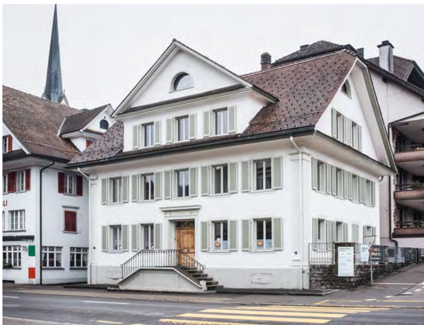
Schüpheim, Arreggerhaus, Ansicht von Nordwesten
