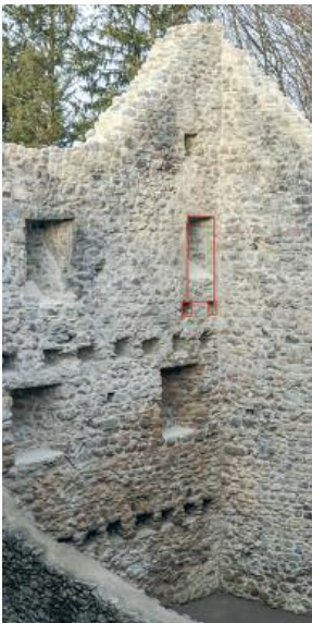
Lage des Aborterker in der Nordostecke des Obergeschosses (links) und Rekonstruktion des Zustands zur Bauzeit (rechts).
