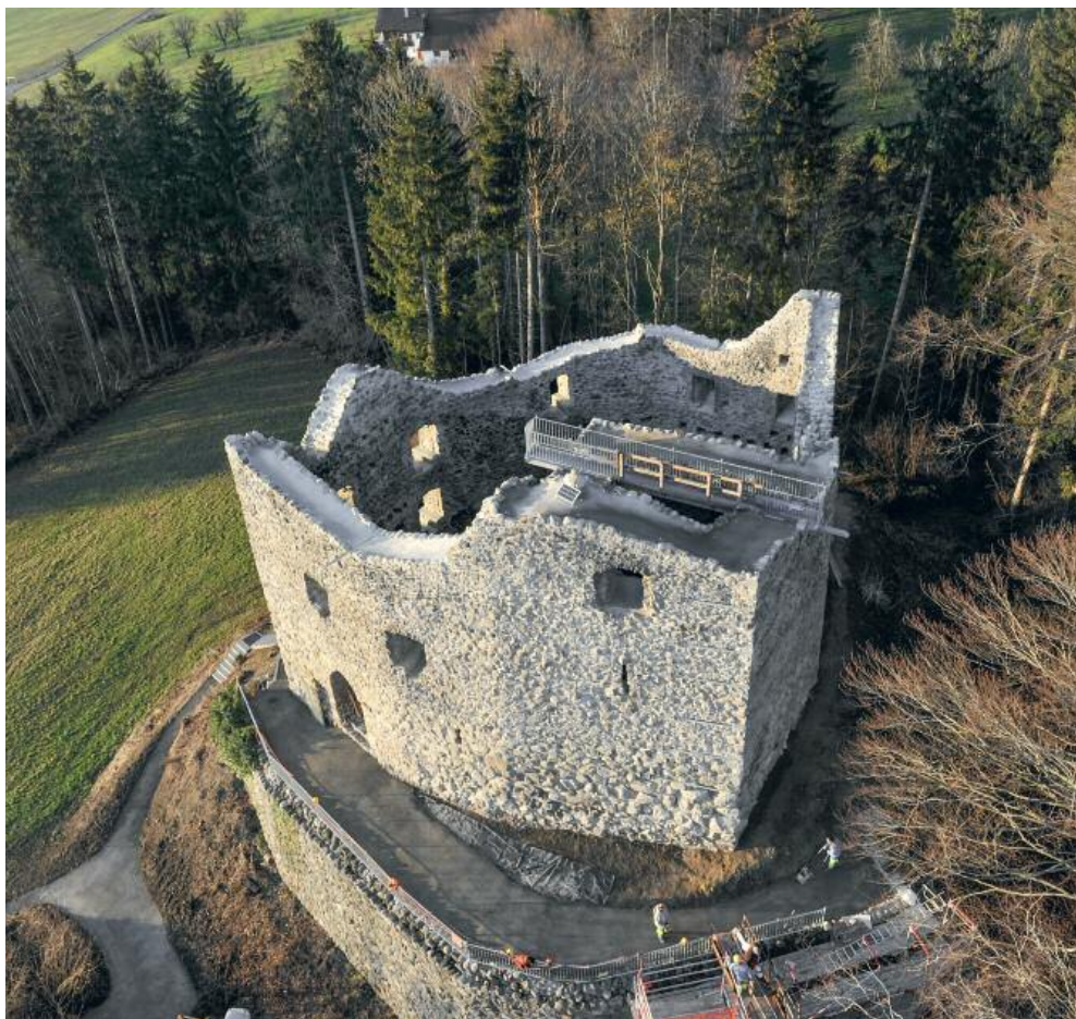
Die Ruine Nünegg nach Abschluss der Restaurierung des Mauerwerks. Noch fehlt die zur Aussichtsplattform führende Wendeltreppe. Die Aussichtsplattform ist der grosszügigen Unterstützung der Albert Koechlin-Stiftung und der P. Herzog-Stiftung zu verdanken.
