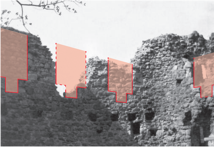
Ansicht an die innere Mauerschale gegen Westen mit zugemauerten oder zu einem Scharfenfenster umgebauten Sitznischenfenstern. Aufnahme 1930
