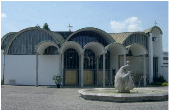
Emmen, Seetalstrasse 18, Pfarrkirche St. Maria
