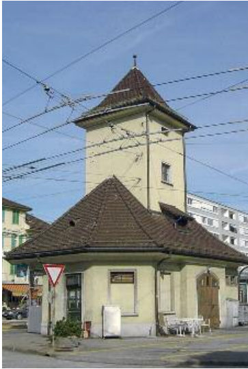
Emmen, Gerliswilstrasse 29, Tram- und Transformatorengebäude
