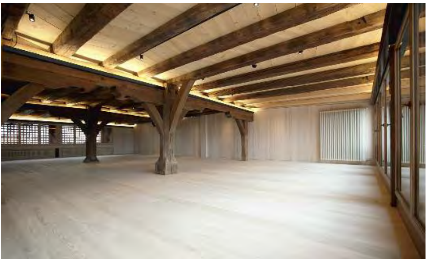
Abb. 31 Die Tuchlaube ist jetzt wieder als Einheit erlebbar. Als Marktort für Textilien waren trockene, gut durchlüftete Räume notwendig. Zustand nach der Restaurierung.
