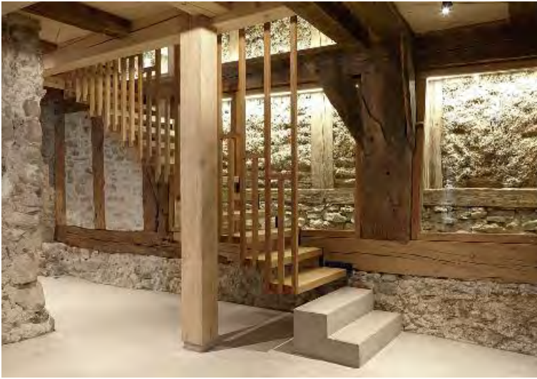
Abb. 69 Eine Trouvaille des neuen Rathausmuseums in Sempach. Das freigelegte Stück Hausmauer, das zum nördlich angrenzenden Nachbarhaus gehört, wird zum ebenso seltenen wie ungewöhnlichen «Museumsobjekt». Sein genaues Alter lässt sich zwar nicht nachweisen. Eine bis in die Bauzeit zurückreichende Entstehung scheint aber nicht ausgeschlossen. Zustand nach der Restaurierung.
